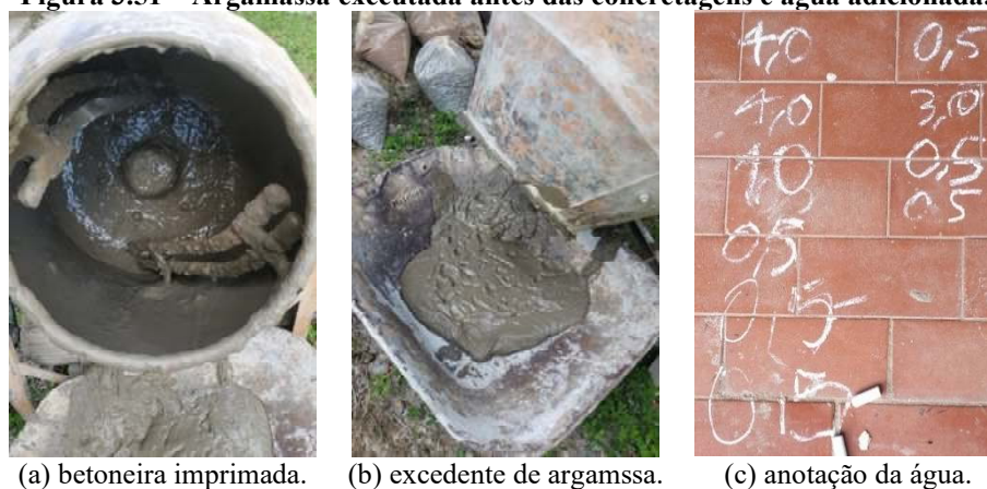
Figura 3.51 – Argamassa executada antes das concretagens e água adicionada.
